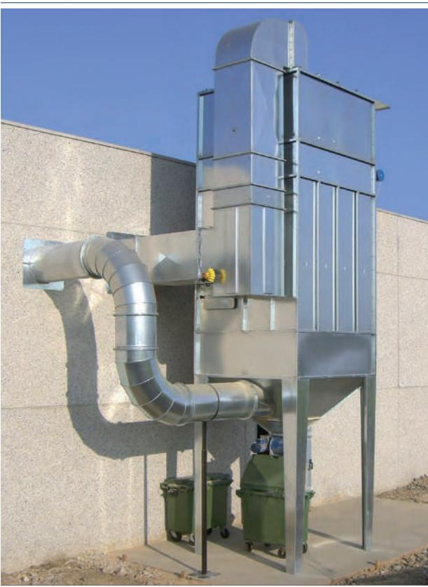
Esempio di AIRCOM/L con Tubazione a T per reintegro dell'aria in ambiente con BY-PASS motorizzato e sonda polveri Tribo-Check.
